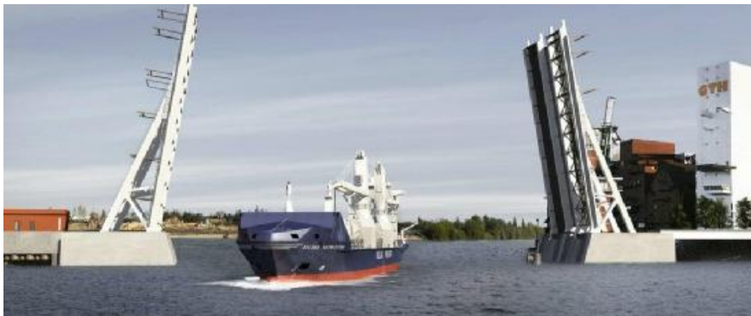
Рис. 1. Разводной мост через Рете в Гамбургском порту
