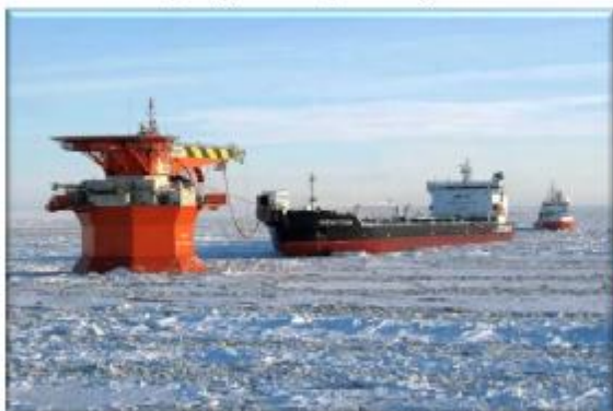
Варандейский терминал – стационарный морской ледостойкий отгрузочный причал
