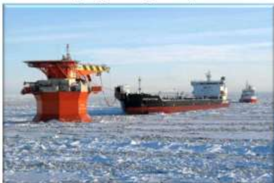
Варандейский терминал – стационарный морской ледостойкий отгрузочный причал
