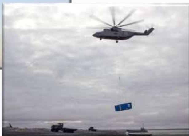
Выгрузка социально-бытового блока вертолётom Ми-26, остров Котельный, 2014 г.
