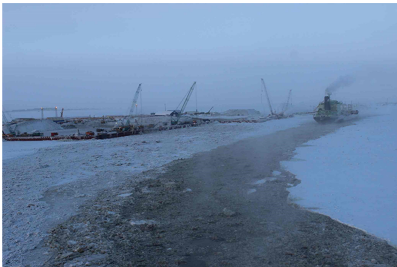
Рис. 2. Скопление битого льда в акватории порта Сабетта
