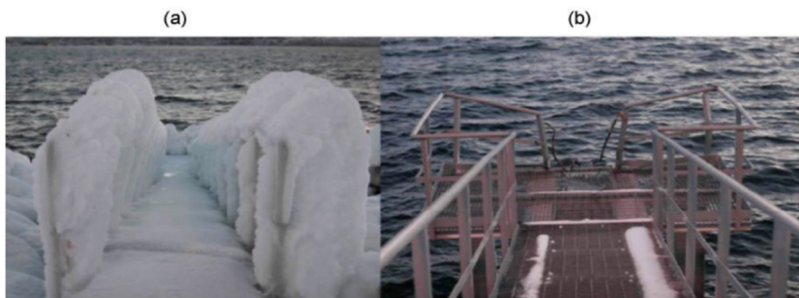
Рис. 1. Экстремальное обледенение: a — швартовные сходни, блокированные наледью; b — после удаления наледи
